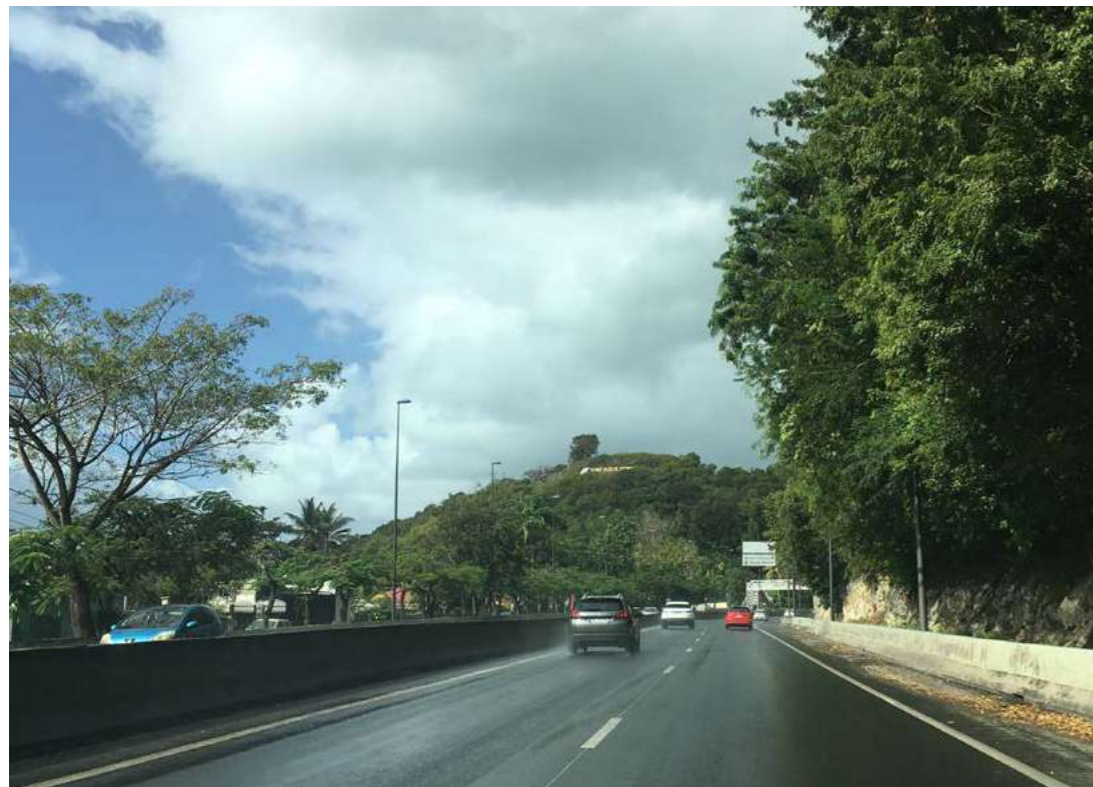
Voie rapide direction Pointe-à-Pitre offrant une vue sur le Fort Fleur d'Épée dans l'axe de la route
