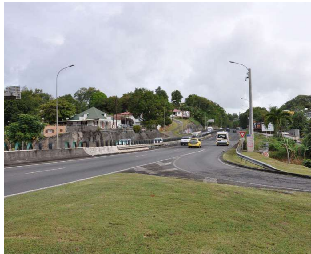
La RN1 traversant les quartiers Boissard et Baimbridge- Fp SIGNES
