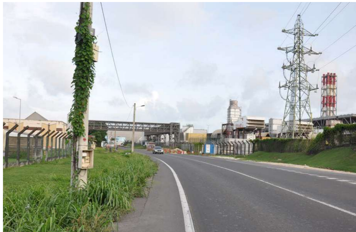
Cheminées, pylônes et silos composent le paysage industriel de la Pointe de Jarry - Fp SIGNES
