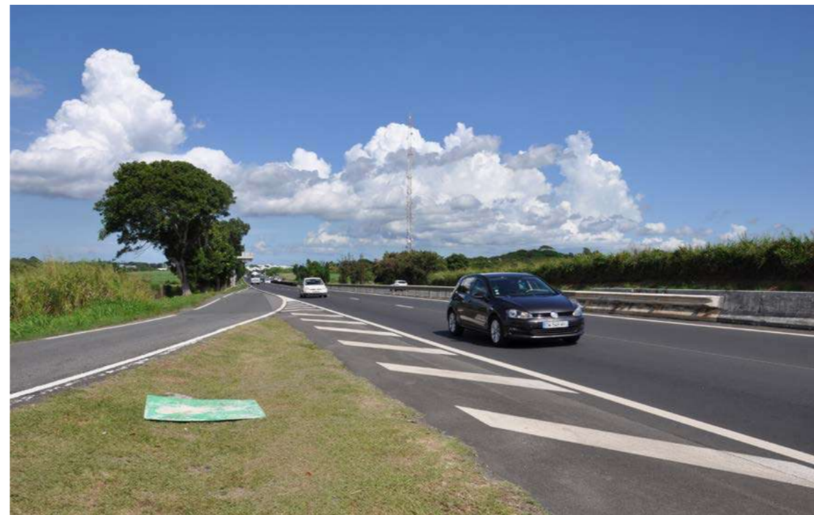
Perception de la RN1 au niveau de l'échangeur de Versailles en direction de Baie-Mahault - Fp SIGNES
