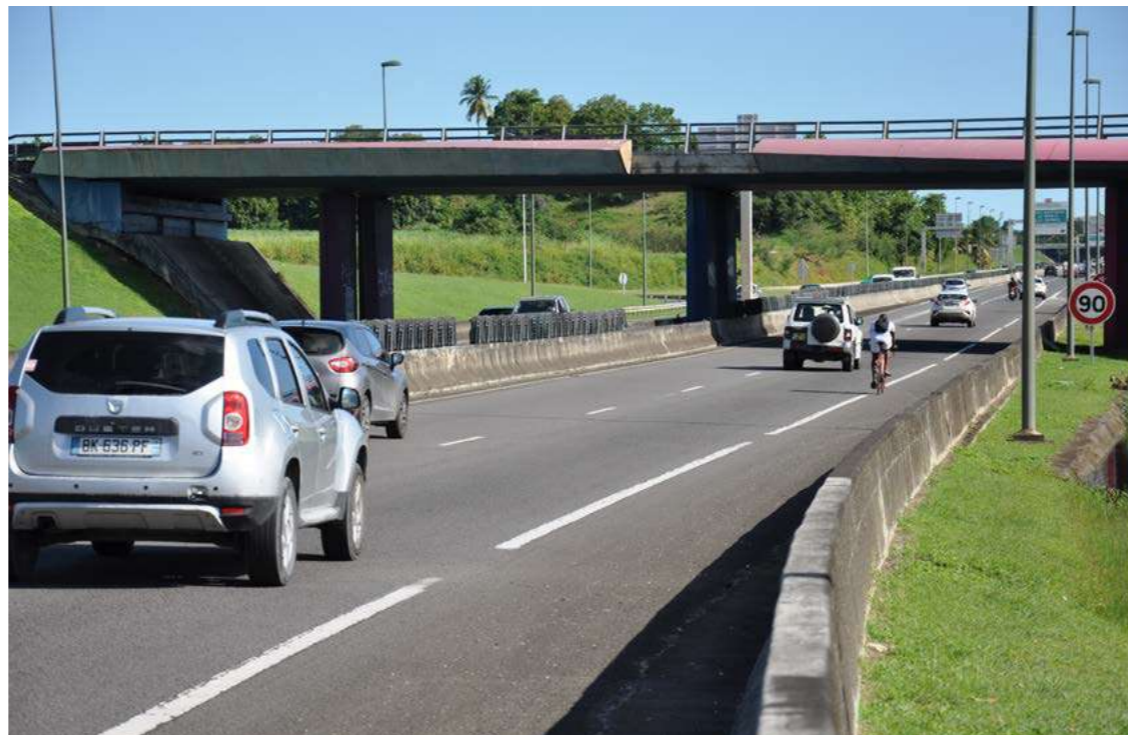
Autoroute urbaine- Fp SIGNES
