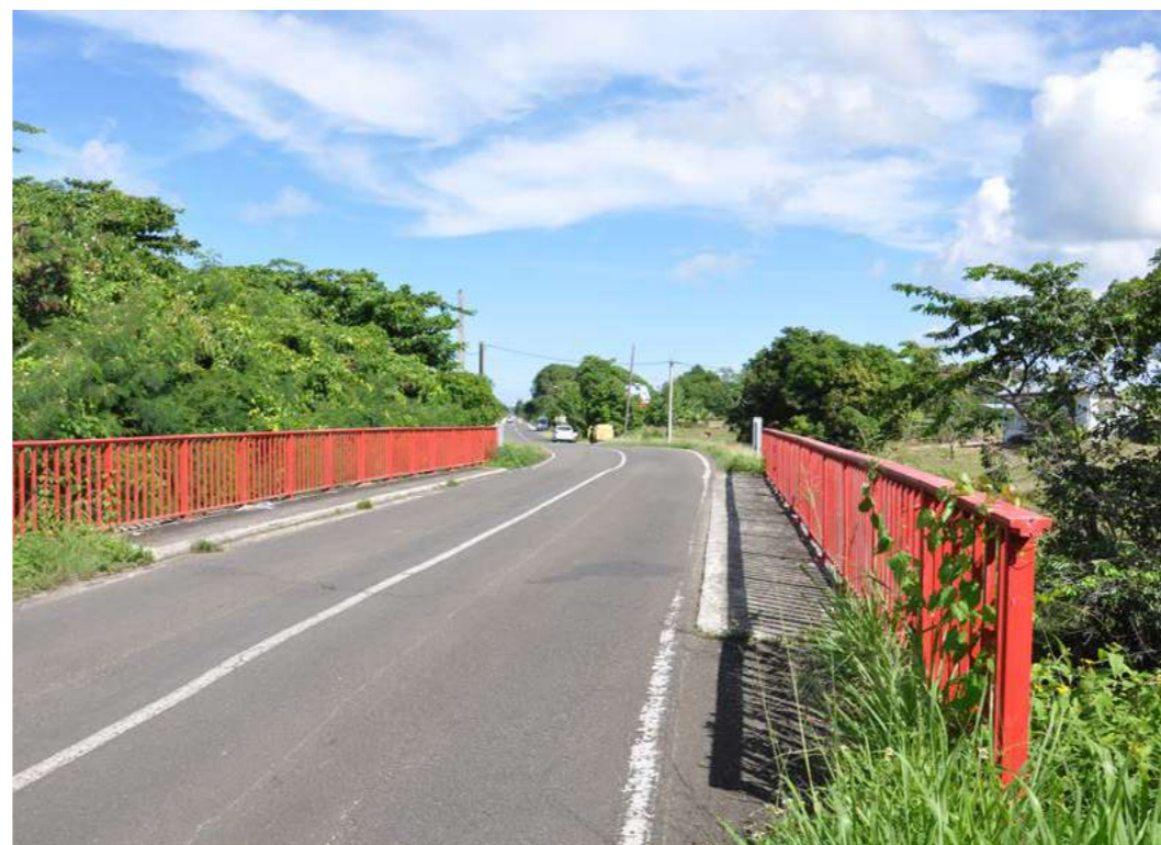
Le pont Rouge sur la rivière Saint-Louis, à l'aval de la rivière, l'ancien pont de type Eiffel noyé dans la végétation- Fp SIGNES
