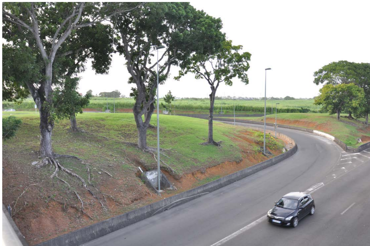
RN2, arbres en bosquet sur l'échangeur de Jabrun à Baie-Mahault
