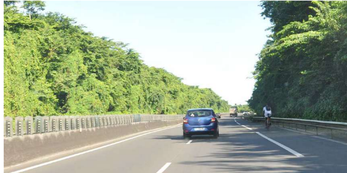
Traversée routière expresse de la forêt marécageuse, entre glissière de sécurité et glissière centrale en béton. Un cycliste circulant sur le bas-côté laisse entrevoir le potentiel de voie verte de l'itinéraire de la RN11 - Fp SIGNES.
