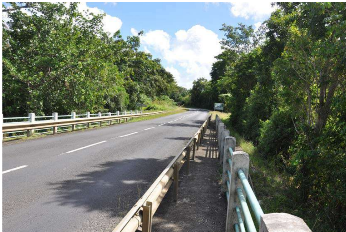
Le pont de Gaschet sur la RN6 et la végétation arborescente de la ravine éponyme - Fp SIGNES
