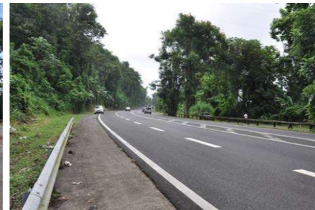
Aire de stationnement sur la RN1 à l'aval du bourg de l'Ermitage - Fp SIGNES
