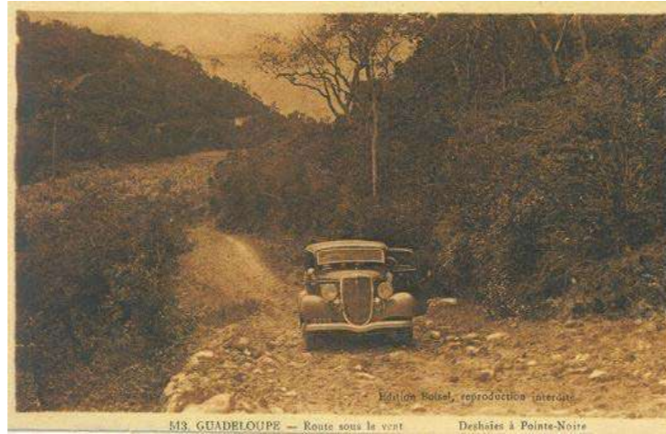
Image d'archive- Route sous le vent ; Deshaies à Pointe-Noire
