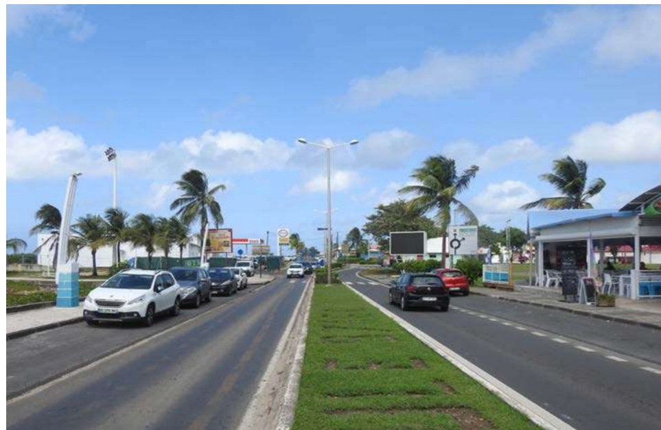
Boulevard littoral urbain du Moule : plus d'1 km de long, emprise large avec terre-plein central végétalisé et son panorama vers l'océan Atlantique - Fp SIGNES
