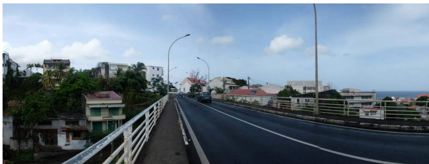
Section de route en viaduc au franchissement de la Rivière aux Herbes, Basse-Terre
