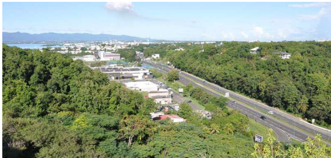
Vue aérienne sur la portion en 2x2 voies depuis le Fort Fleur d'Épée - Fp SIGNES
