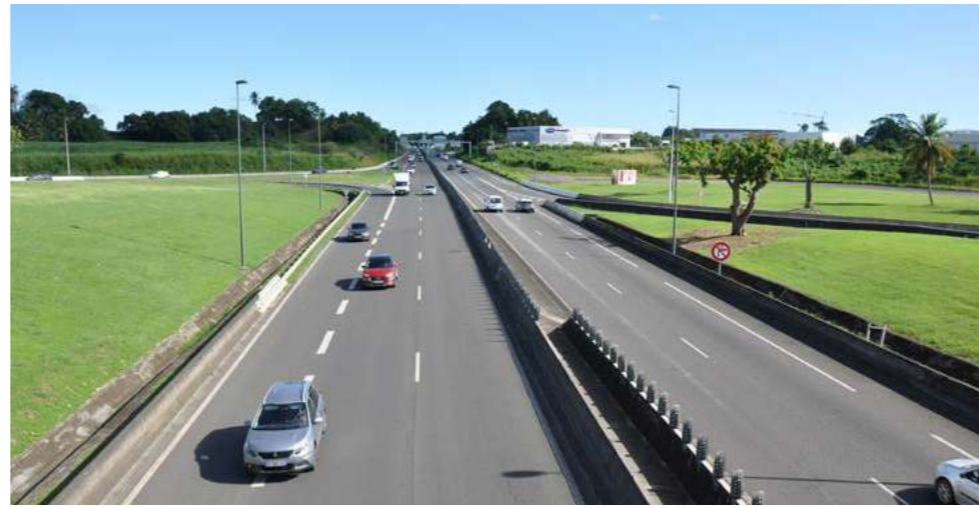
RN11, rocade de l'Alliance au niveau de l'échangeur avec l'aéroport
