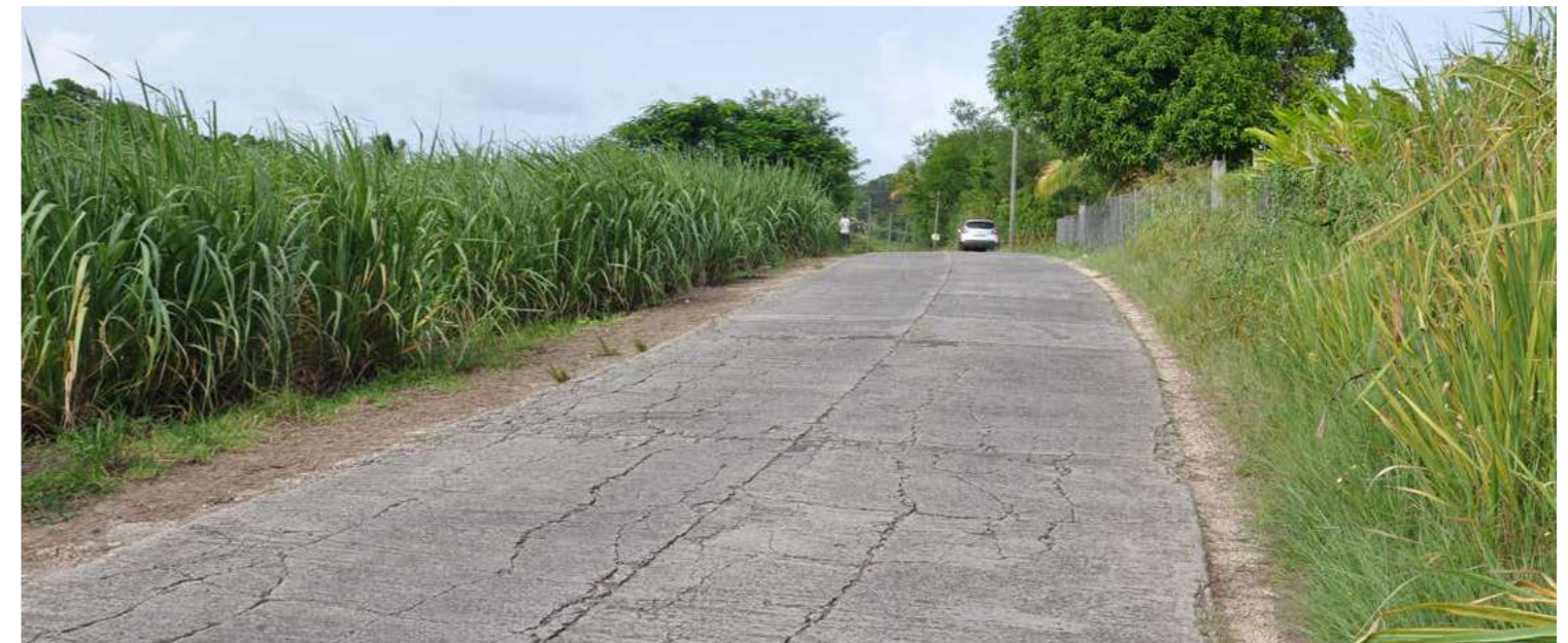
RN8 - ROUTE DES MANGLES
