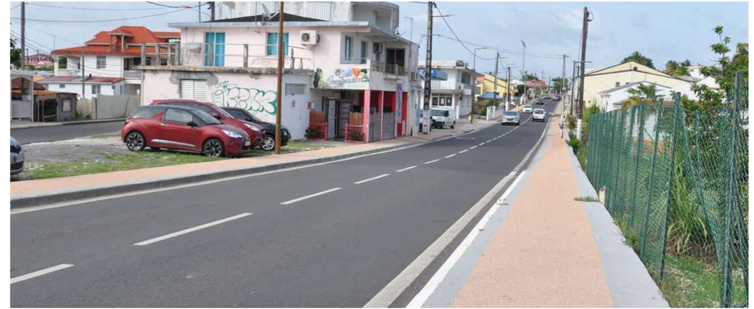
RN6 - ROUTE DE MORNE-À-L'EAU À L'ANSE-BERTRAND
