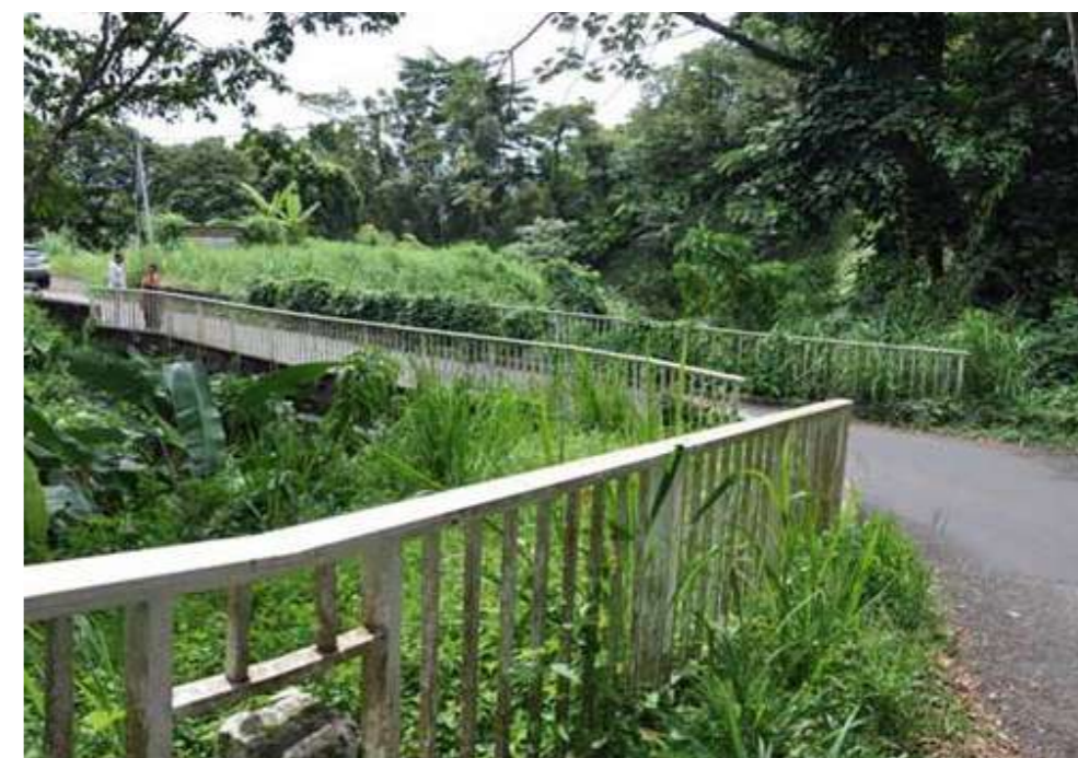
Pont sur la rivière Rouge à Matouba- RN3
