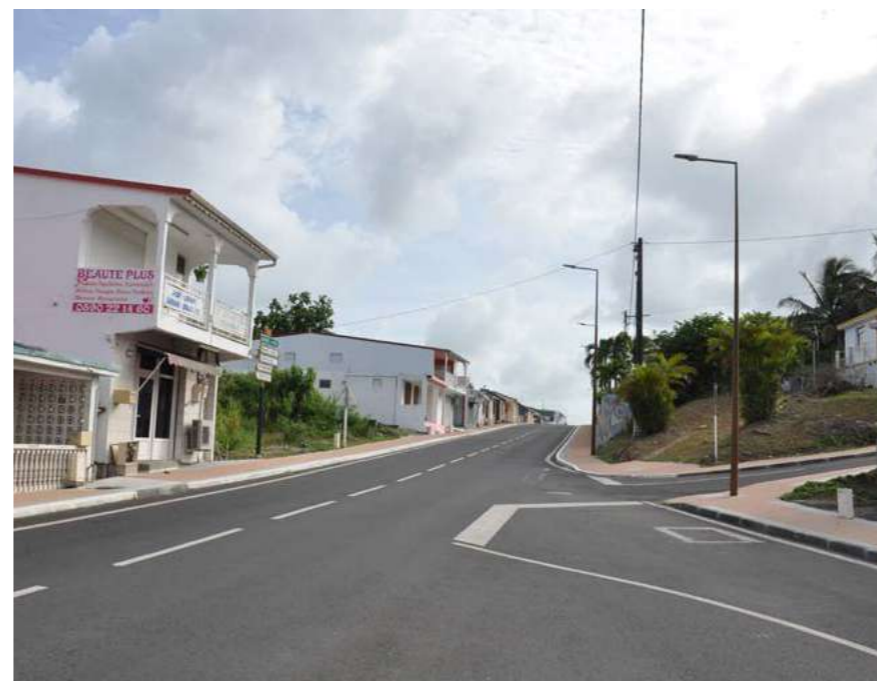
Les aménagements urbains dans Petit-Canal (trottoir coloré et éclairage public) - Fp SIGNES
