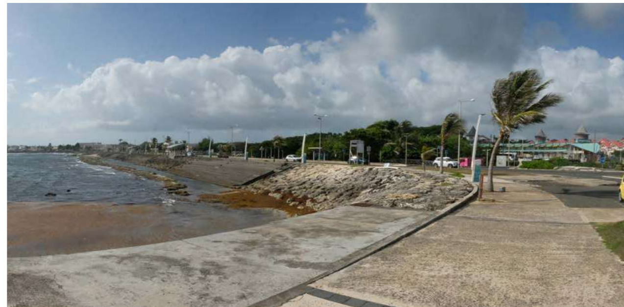
L'aménagement du front de mer (garde-corps, gradins, éclairage et alignement de palmiers) Fp MRuffin
