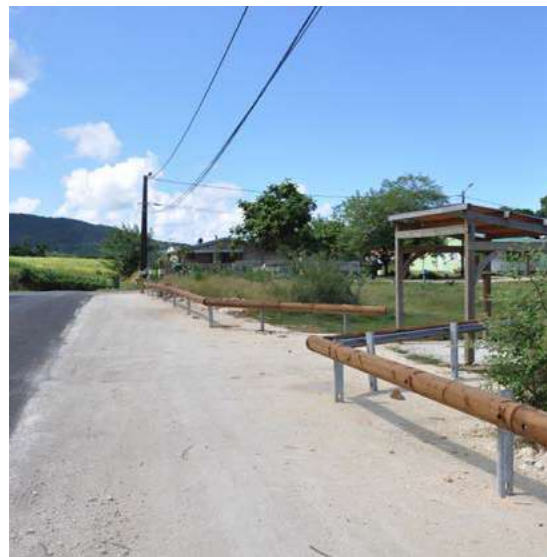
Traitement qualitatif de la glissière en bois-métal compris arrêt bus. Morne Major- Fp SIGNES.
