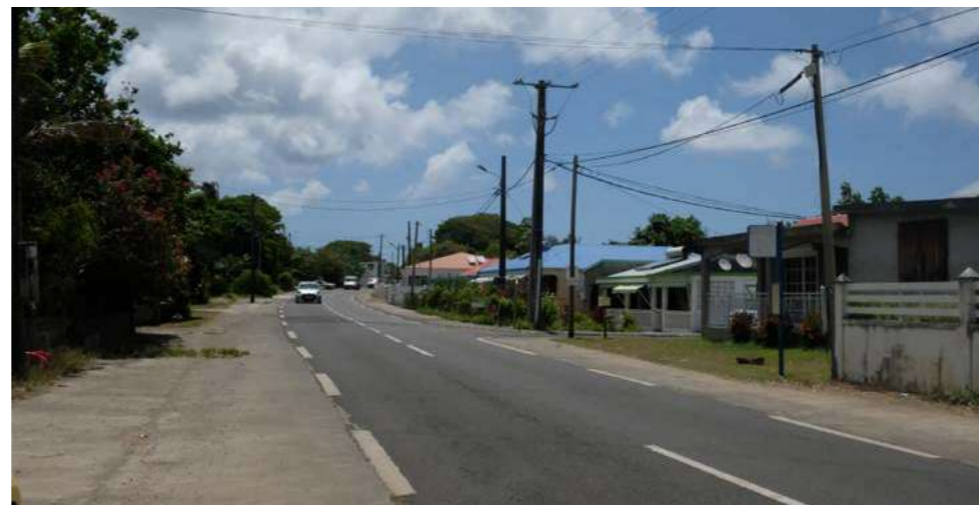
RN8 (sortie d'Anse-Bertrand), route en contexte péri-urbain à 2 voies avec accotements bétonnés.
