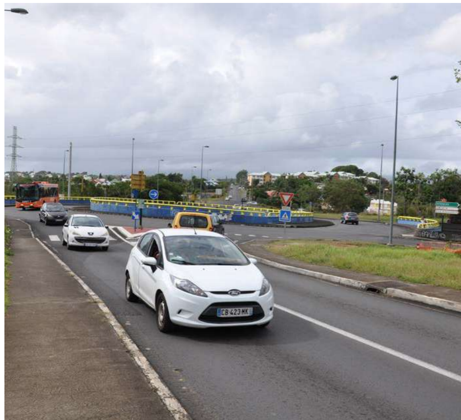
Giratoire « perché » à l'intersection RN2/RN2002, direction Baie-Mahault- Fp SIGNES.
