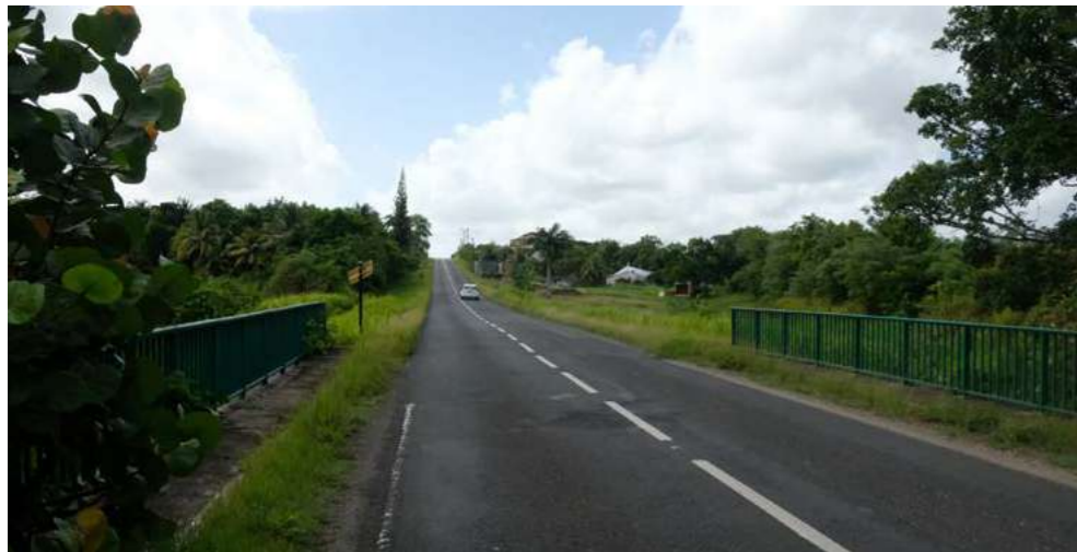
RN6 (ravine Deville), route en contexte rural à 2 voies avec accotements enherbés
