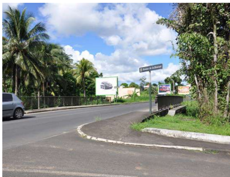
Franchissement de la rivière Ancenneau Fp SIGNES
