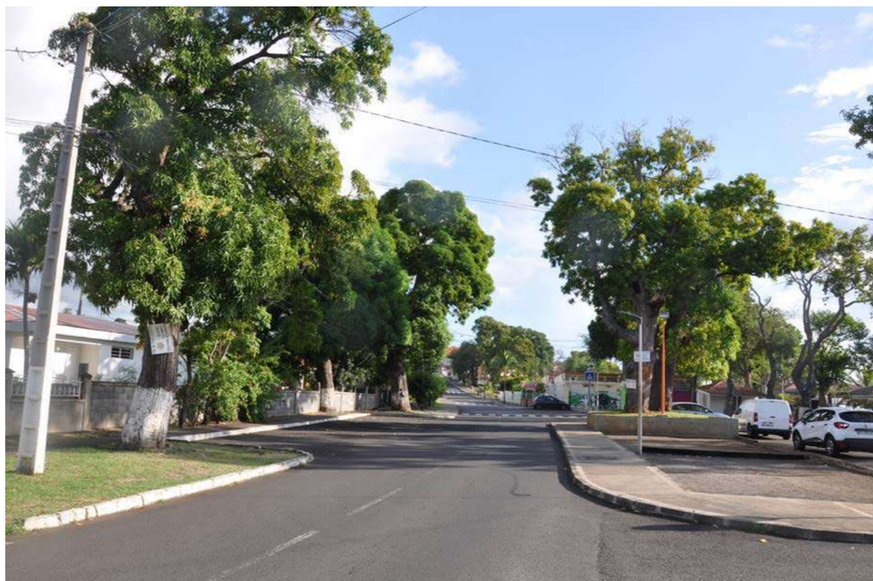
RN2 dans Vieux-Habitants , boulevard des Habissois Souverains- Direction Baillif- Fp SIGNES
