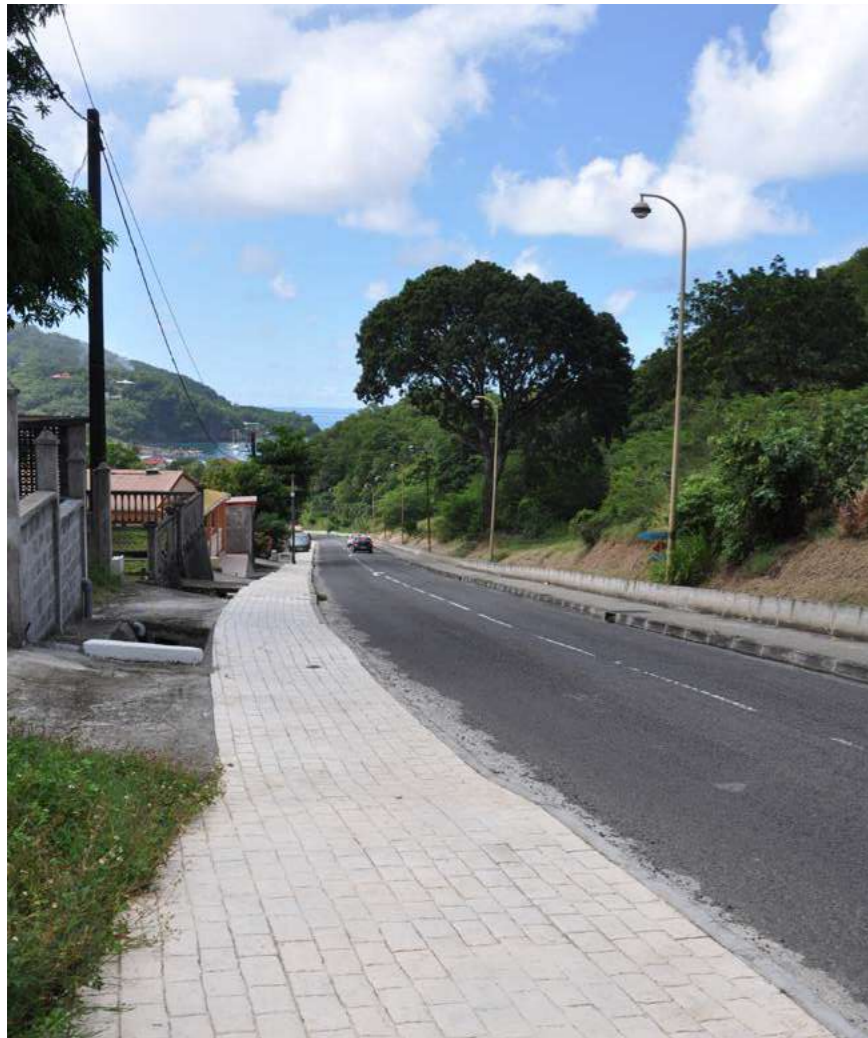
Entrée Nord dans le bourg de Deshaies annoncée par un trottoir borduré à droite et un revêtement de sol pavé à gauche - Fp SIGNES.
