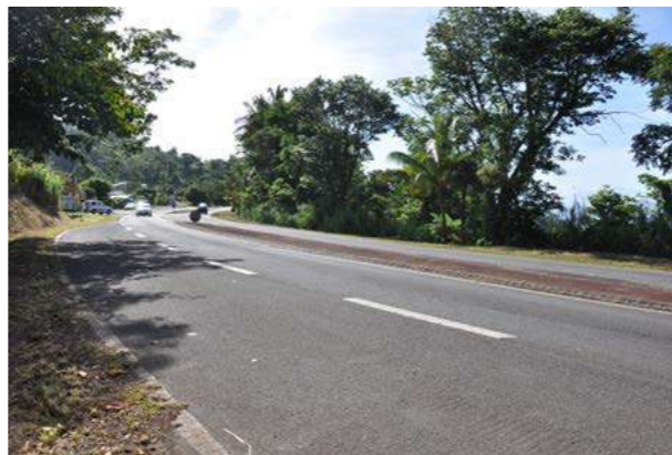
Carrefour RN1 et bourg de Grand Fond, des fenêtres sur le grand paysage sont à imaginer Fp SIGNES
