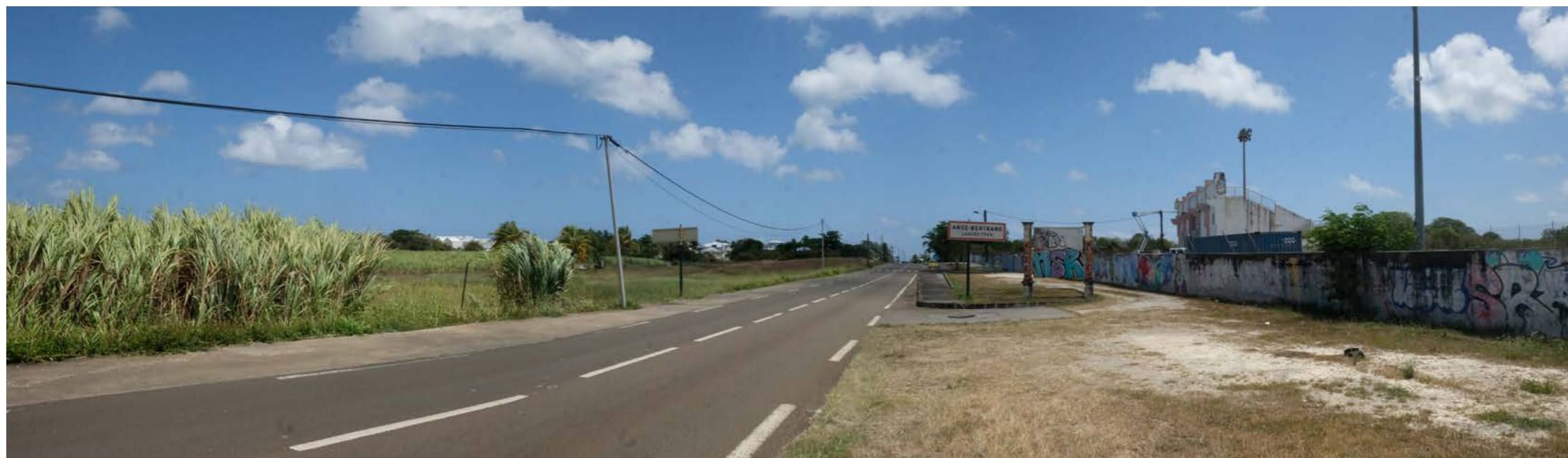
Entrée dans Anse-Bertrand : voie rectiligne, largeur continue, accotements et trottoirs bétonnés - Fp MRuffin
