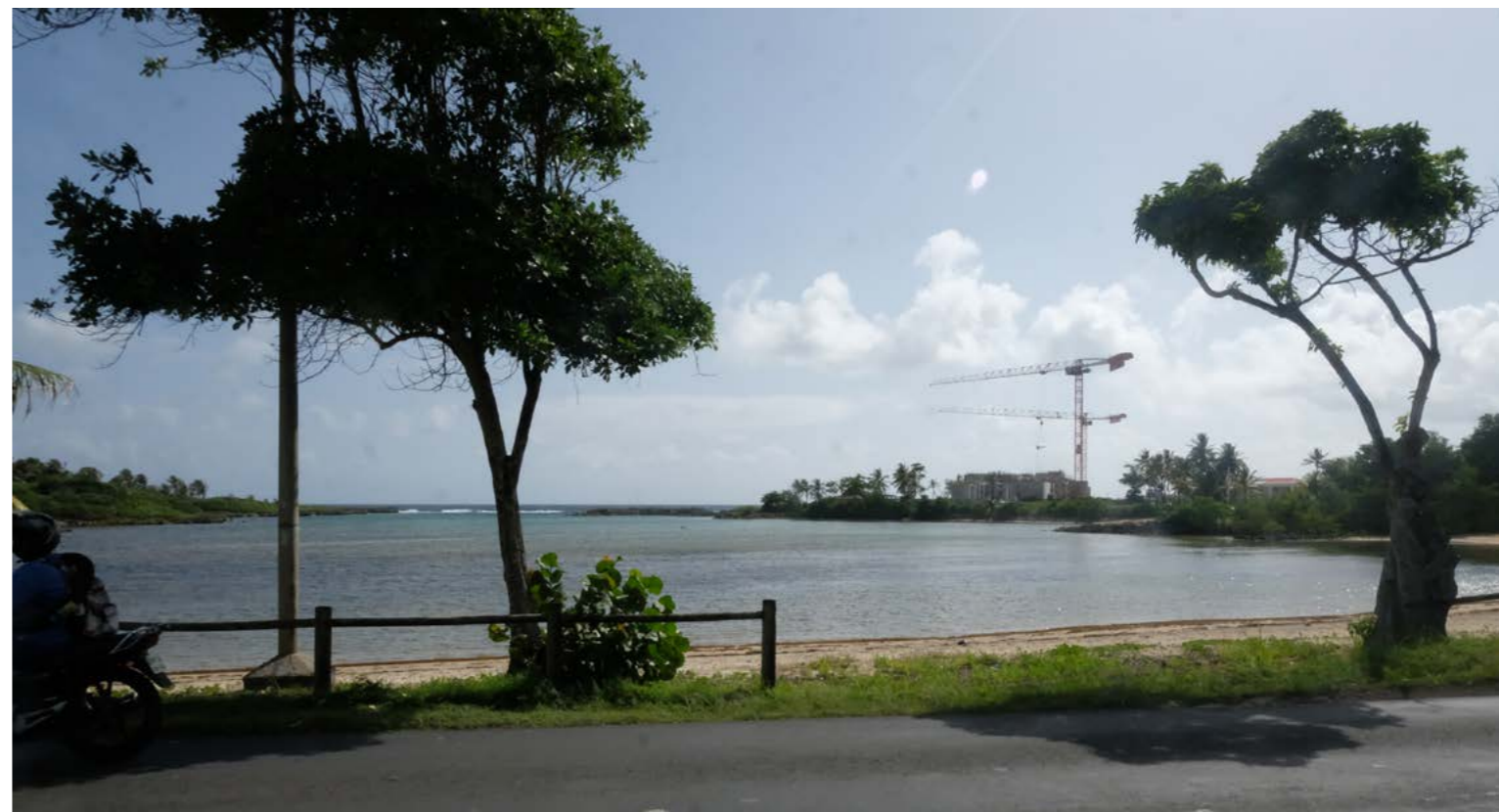
Traversée de la plage de la Baie du Nord-Ouest à l'entrée de Moule- Fp MRuffin
