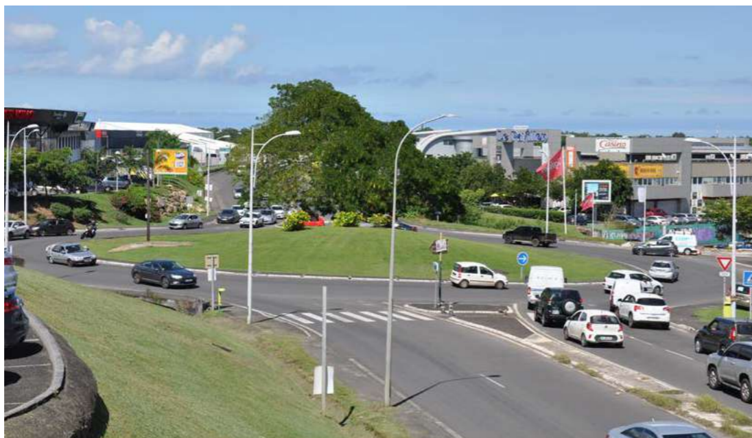
Giratoire à l'intersection RN10 / RD32 : de vastes espaces engazonnés caractérisent l'infrastructure du rond-point et les talus adjacents. Des arbres de moyen développement apportent de l'ombrage aux parkings sans masquer les enseignes commerciales - Fp Signes
