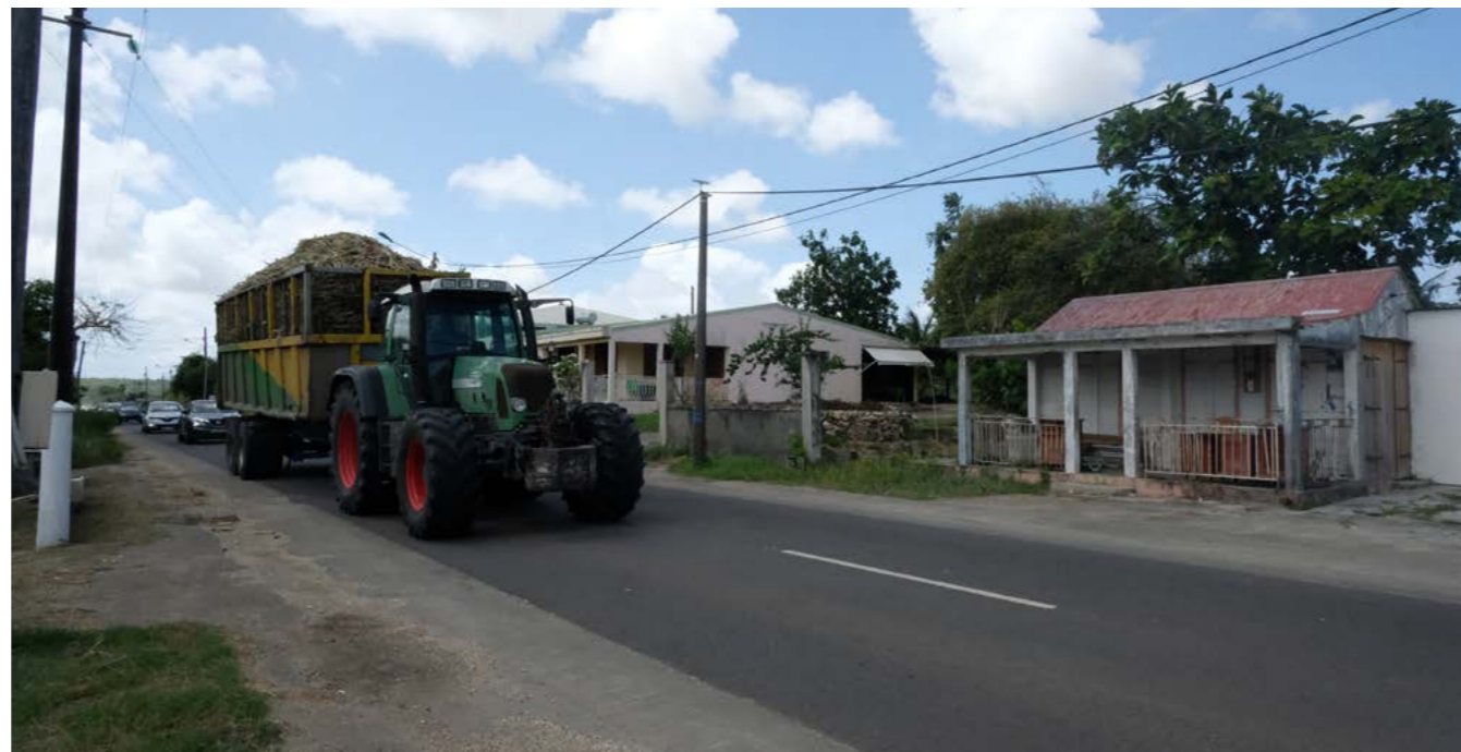
Limite public/privé étriquée, accotements bétonnés et fossés de drainage couverts à Beauplan - Fp MRuffin
