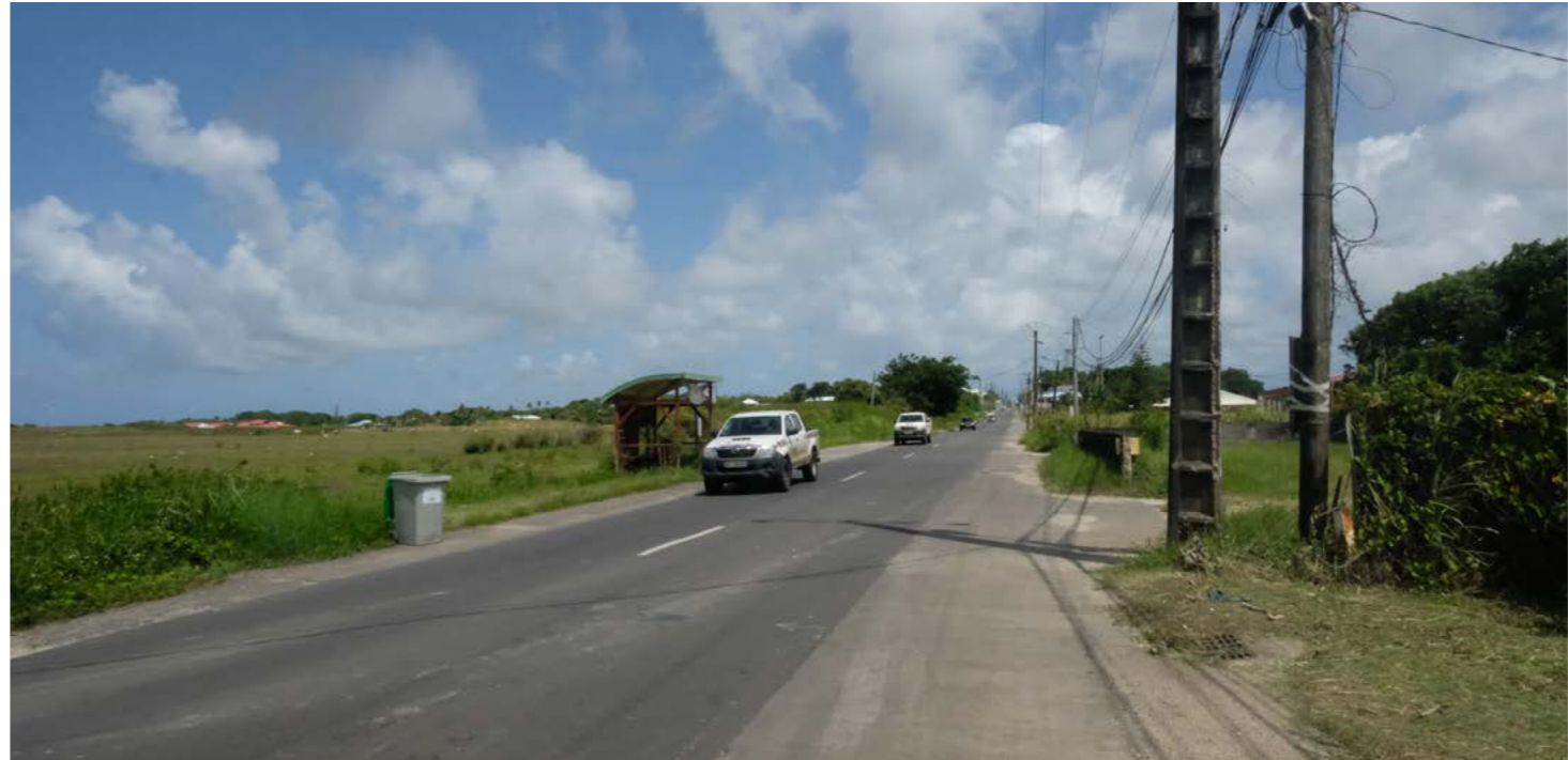
Rare coupure d'urbanisation entre les Mangles et Beauplan permettant de percevoir le paysage rural - MRuffin
