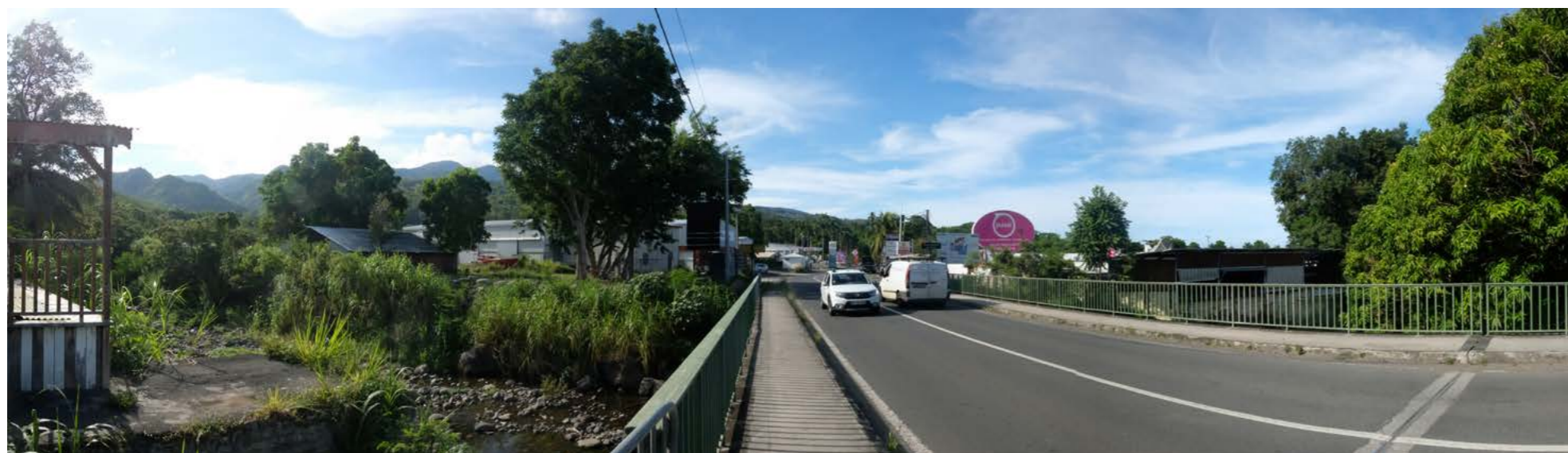
Traversée de la Rivière Losteau suivie de la zone commerciale installée sur les terrains plats de la plaine alluviale Fp MRuffin
