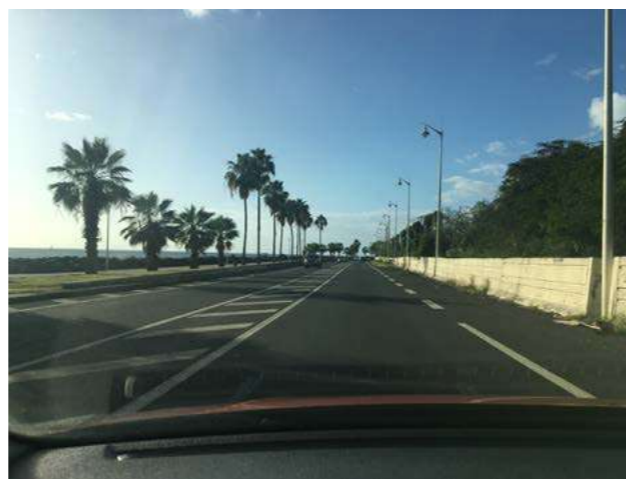
La RN1 devient le Boulevard Certy Archimède dans Basse-Terre en front de mer- Fp SIGNES
